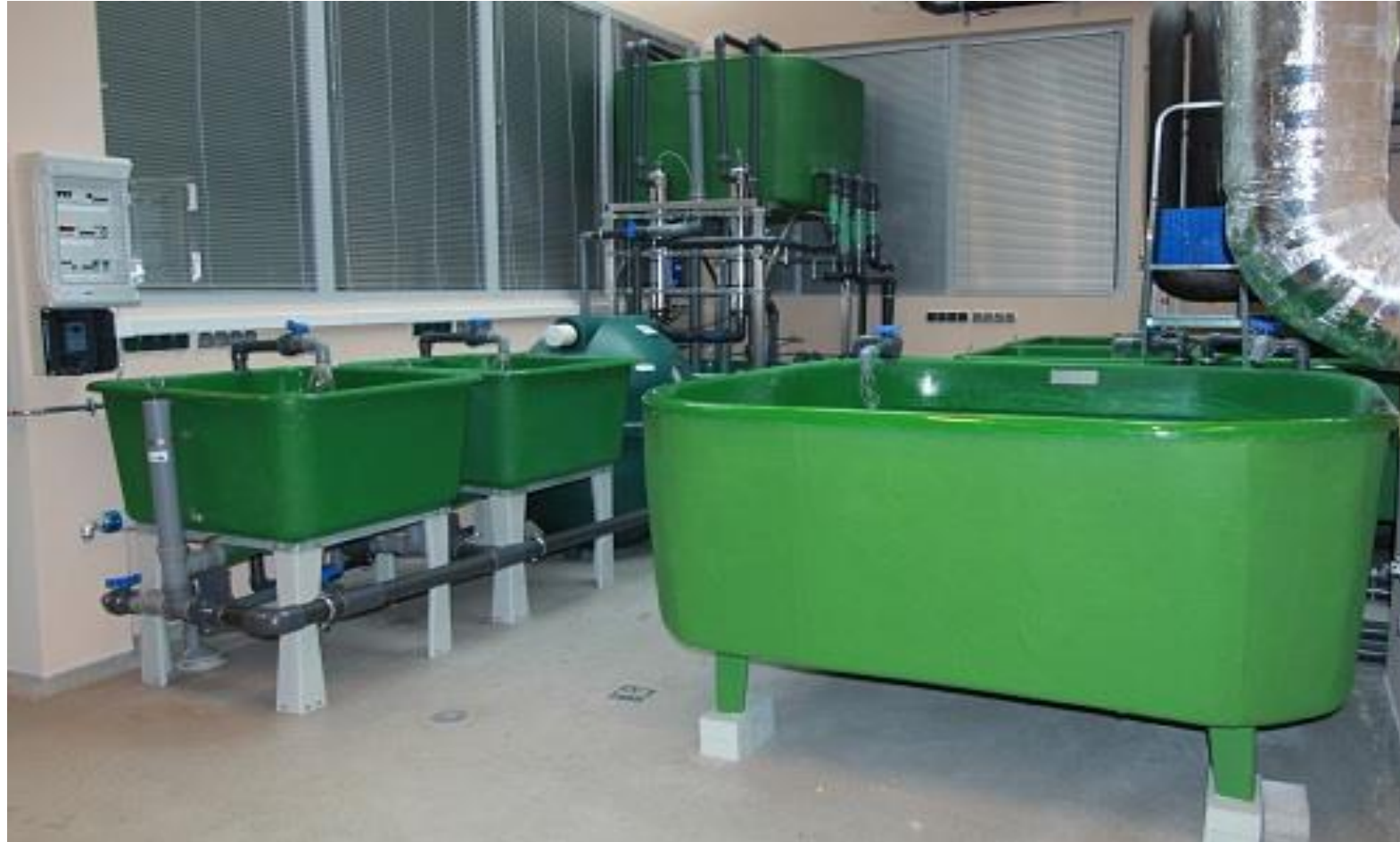
Fot. 1. RAS tarlakowy będący na wyposażeniu Centrum Akwakultury i Inżynierii Ekologicznej w Olsztynie.
